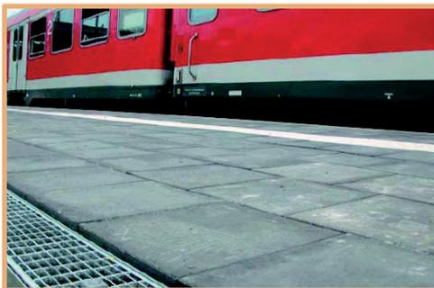
Canali con profilo in acciaio zincato ed accessori per il drenaggio delle acque classe di carico C250 con griglie con sistema di fissaggio centrale tipo Clipfix oppure Standard a farfalla
