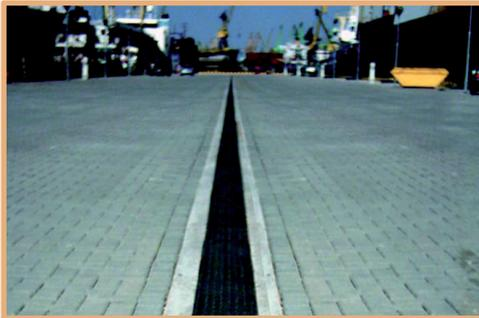
Canali con profilo in ghisa per il drenaggio delle acque classe di carico F900 con griglie in ghisa e sistema di fissaggio Standard a bulloni
