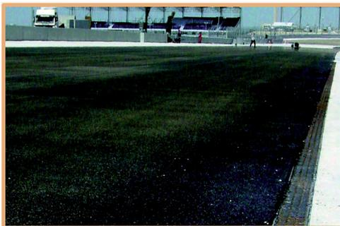
Canali con profilo in ghisa per il drenaggio delle acque classe di carico E600 con griglie in ghisa e sistema di fissaggio Standard a bulloni
