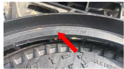
Sedi di appoggio della guarnizione sul telaio.
